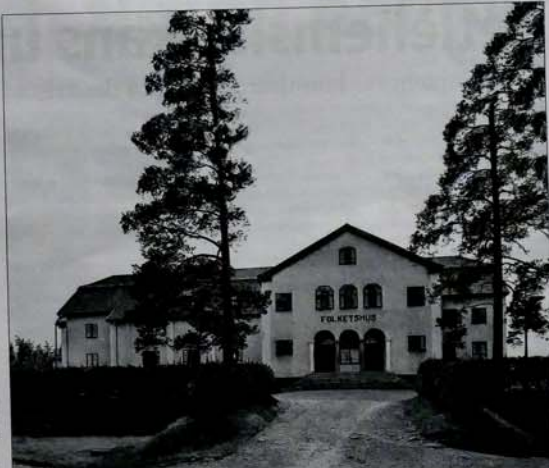
Bild på den ståtliga byggnad som var Skoghalls Folkets hus, invigd 5 februari 1928.
